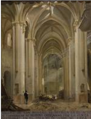
Derribo de la parroquia de San Miguel . Francisco Peralta (1868)
